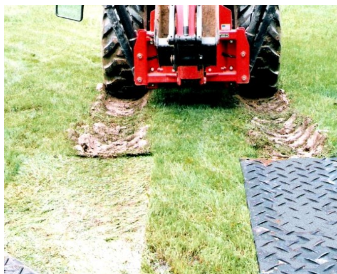
Figure 36. Exemple de résultat d'utilisation de plaques de roulage sur un sol
