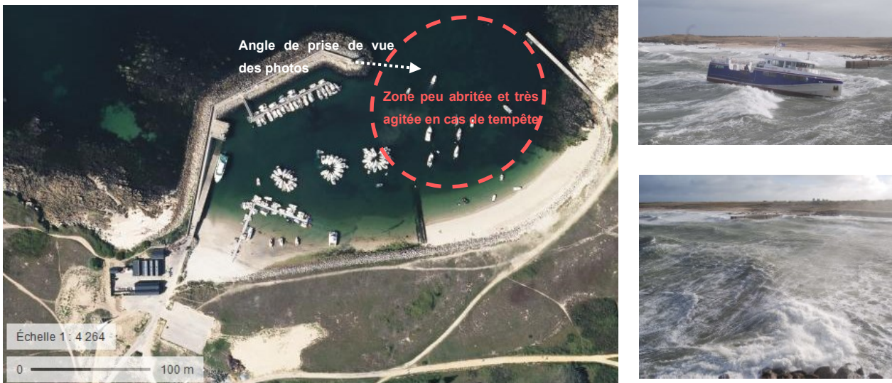
Figure 1. vue aérienne du Port de l'Argol et problématique
